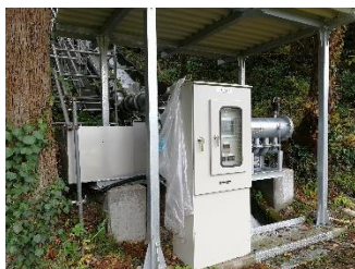
マイクロ水力発電(10kW)
