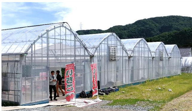
ICT環境制御 連棟ハウス(12a)
